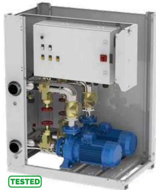
Auf Anfrage ist es möglich, Versionen mit Sonderausstattung für den Betrieb bei Temperaturen und Drücken außerhalb der üblichen Einsatzgrenzen zu erstellen. Zu diesen Konfigurationen gehören beispielsweise eine erhöhte Isolierung, Frostschutzsätze, Pumpen für den Betrieb bei niedrigen Temperaturen, Anschlüsse aus Edelstahl.
